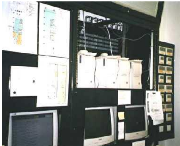
ห้องควบคุมงานระบบของอาคาร ด้านซ้ายมือ จะเห็น แผงวงจร ควบคุม ที่ต่อจาก ระบบ ปรับอากาศ ของอาคาร แต่ละชั้น มา รวมกันที่ห้องนี้ และ ระบบนี้ จะเชื่อม เข้า เครื่องคอมพิวเตอร์กลาง เพื่อ ความสะดวก ในการควบคุมระบบ ทั้งหมด จากจุดเดียว
