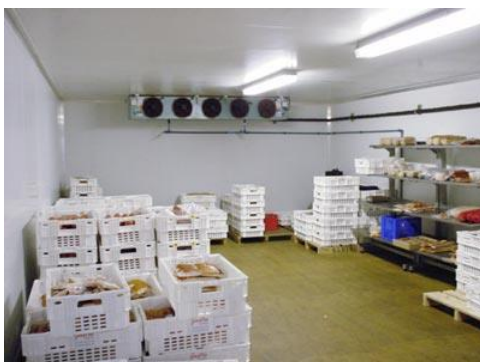
รูปที่ 5-8 ห้องแช่แข็งแบบการพาความร้อน (ห้องเย็นในห้างสรรพสินค้า)
