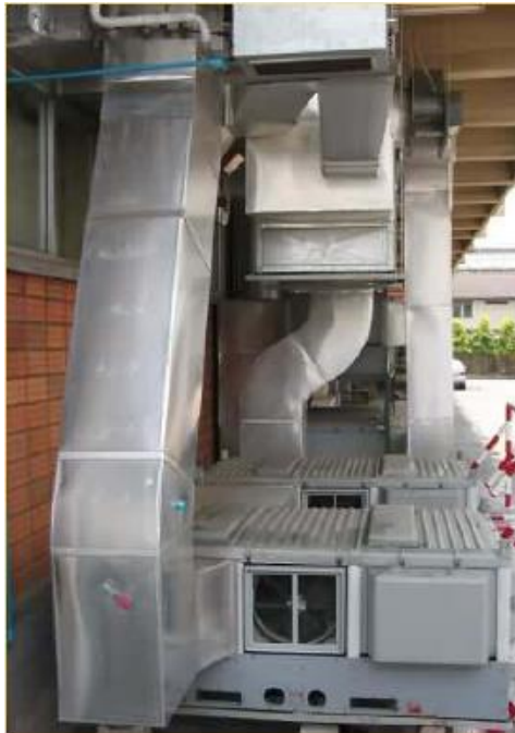
รูปที่ 5-1: ระบบลดความชื้นด้วยสารดูดความชื้นเหลวที่ติดตั้งในโรงงานผลิตยา (4)
