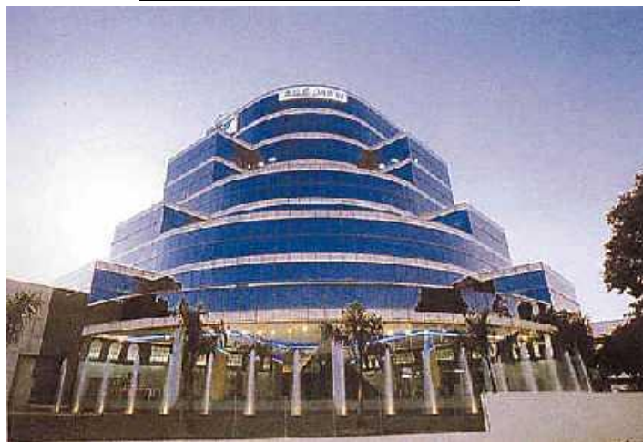
อาคาร A.C.E. DAIKIN COMPLEX
