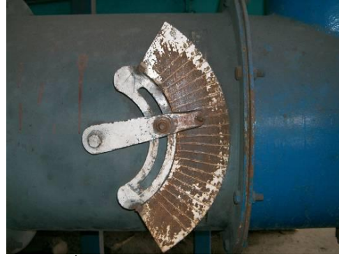
รูปที่ 6-28 พัดลมเป่าทรายและการปรับหรีดแอมเปอร์
