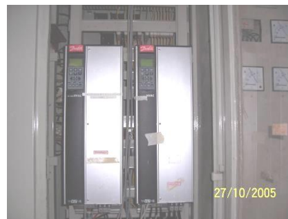
ภาพหลังปรับปรุงของมอเตอร์ปั๊มน้ำกากของเสี้ยน
