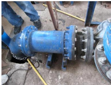
รูปแสดงปั้มน้ำและท่อเฟล็กที่ชำรุด
