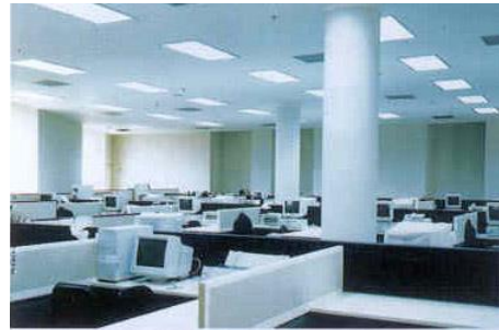
รูปที่ 3-27 ลักษณะของการกระจายแสงสว่างของดวงโคมแบบกระจายแสงสว่างลงด้านล่าง (Direct Luminaire)
