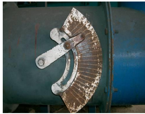
รูปที่ 6-29 ใบพัดของพัดลมเป่าทรายอันใหม่และการปรับแอมเปอร์พัดลมใหม่ (หรีดให้น้อยลง)
