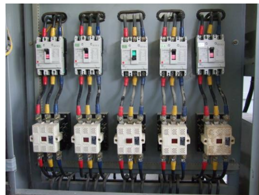
รูปที่ 2-15 Power Factor Controller และอุปกรณ์ตัดต่อ Cap Bank
