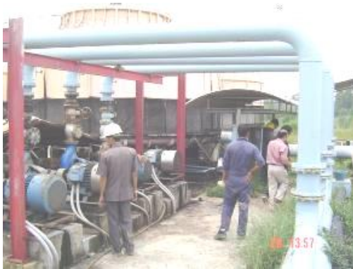
สภาพปั๊มน้ำหล่อเย็นก่อนปรับปรุง
